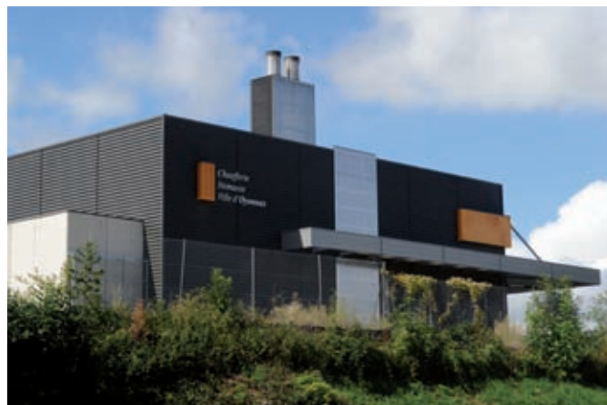
La nouvelle chaufferie biomasse a permis une baisse de 40% des factures énergétiques des foyers reliés au chauffage urbain.
