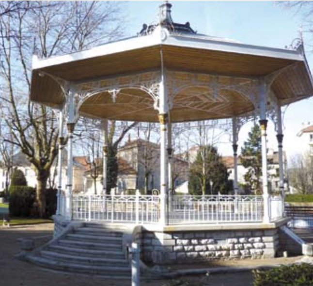
Le kiosque rénové du parc René Nicod.
