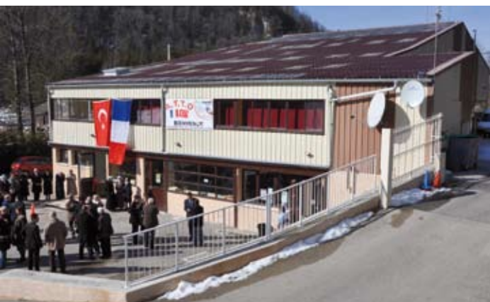
L'ATTO dispose désormais d'un local neuf de 1200 m 2 , route de Geilles.
