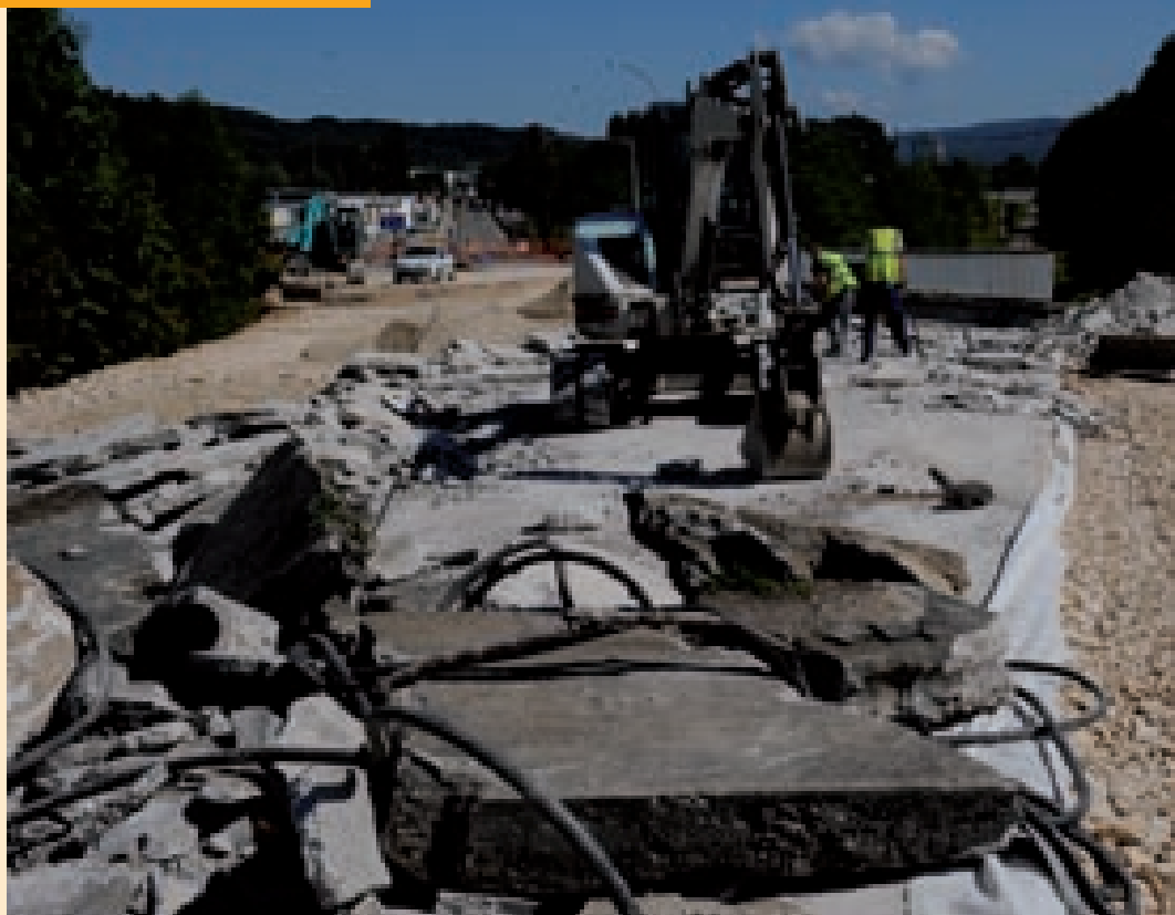
Pont SNCF, cours de Verdun : un chantier de plusieurs semaines
