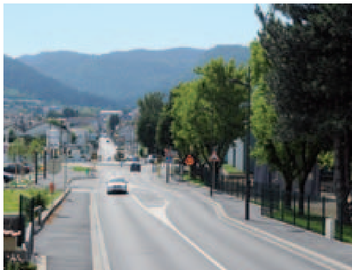
Rue Jules Michelet, trottoirs élargis et nouvelle voirie : plus de sécurité !
