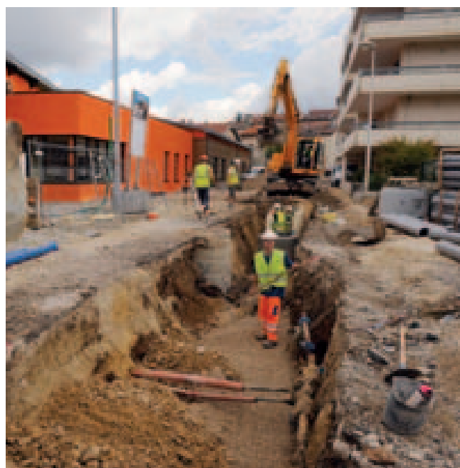
Travaux de réseaux et voirie, rue du Maquis, avant l'ouverture de l'école Simone Veil
