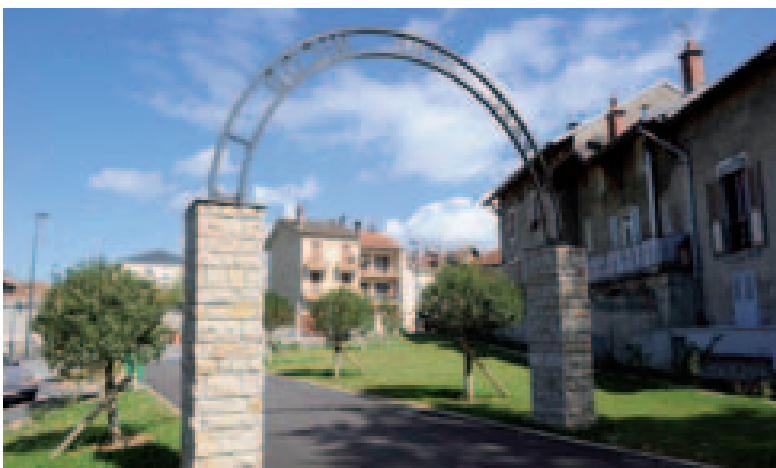
La démolition de l'usine Bollé ouvre le parc René Nicod sur la rue Tacon
