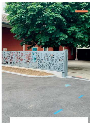
ÉCOLE DE LA VICTOIRE Remplacement du portail d'entrée
