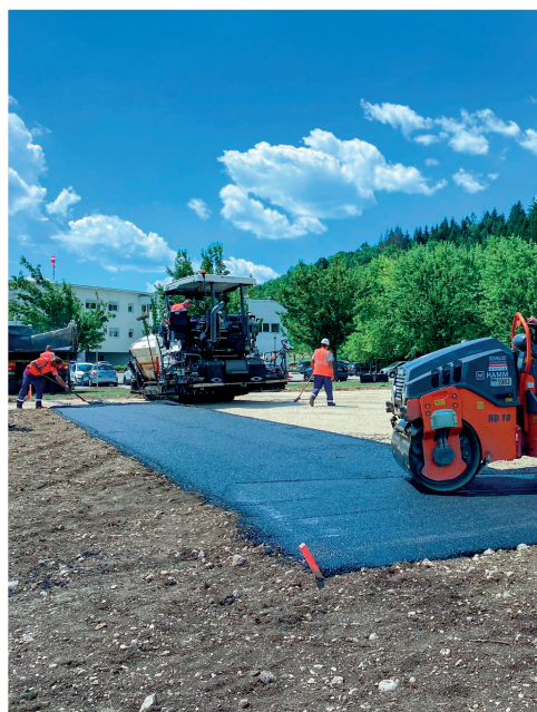
AMÉNAGEMENT D'UNE HÉLISURFACE, Juillet
